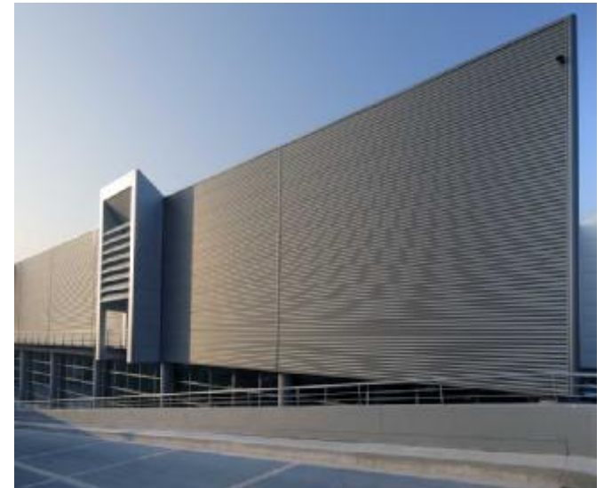
Lo stabilimento La sede principale della Mevis a Rosà
